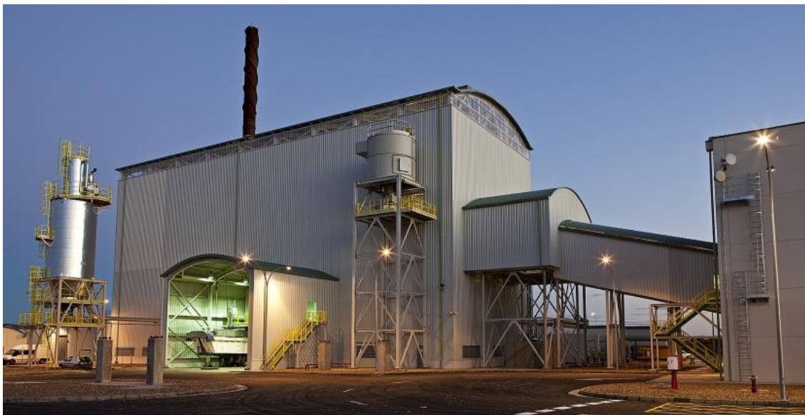
Figura 8: Planta BIOMASA MIAJADAS, S.L, situada en Miajadas.
