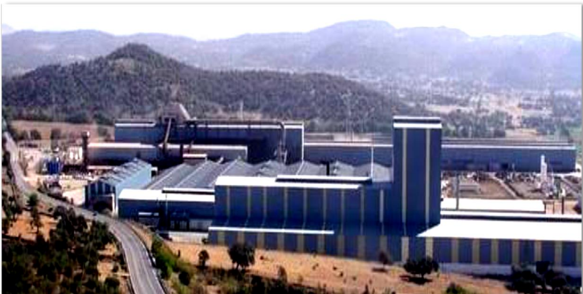
Figura 9: Instalaciones de AG Siderúrgica Balboa S.A, en Jerez de los Caballeros.
